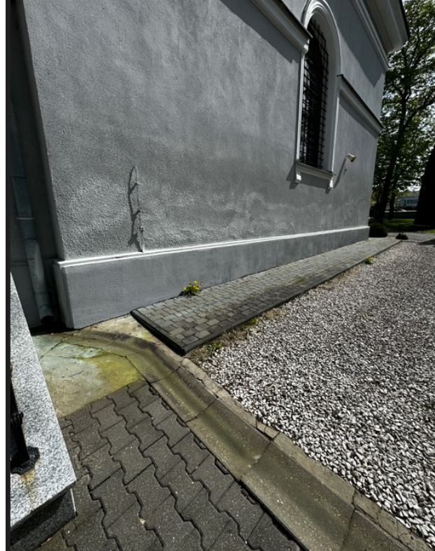
Fot.5. Stan techniczny odwodnienia liniowego na elewacji zachodniej, źródło: fotografie własne
